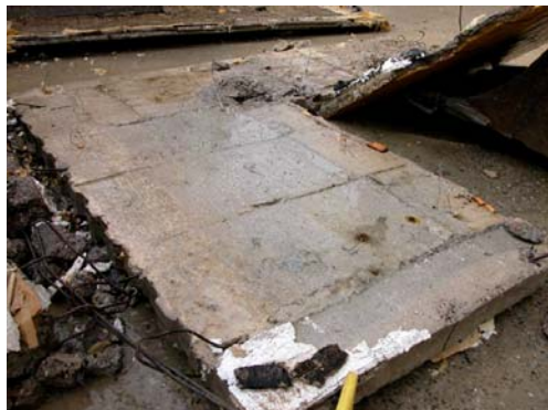
gereinigte Betonfläche optisch kein Kamilit mehr sichtbar
