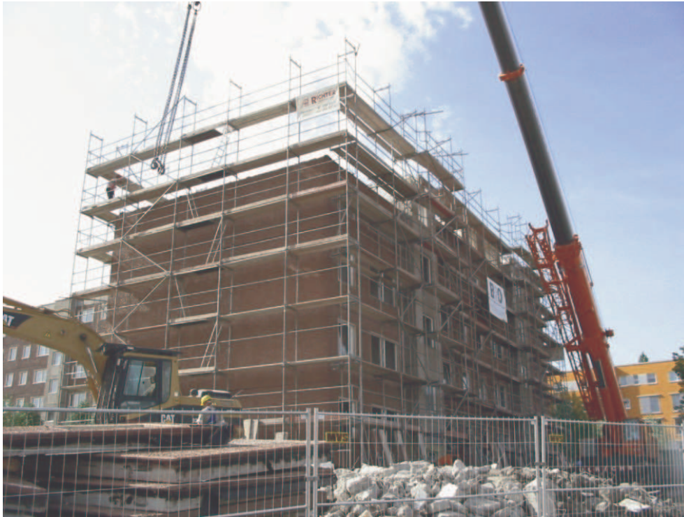
Bild 5: Fassadengerüst als kollektiv wirkende Schutzmaßnahme beim segmentweisen Rückbau
