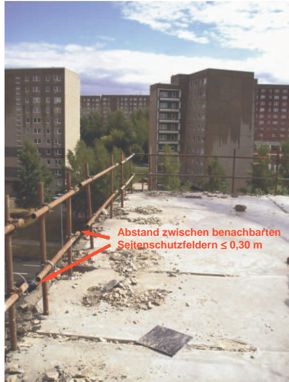
Bilder 2 und 3: Umlaufender Seitenschutz als kollektiv wirkende Schutzmaßnahme, Ausführung mit Geländerholmen und Kupplung
