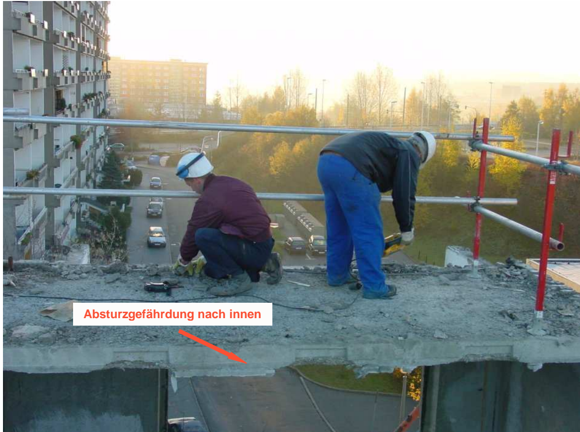
Bild 1: Spitzarbeiten zum Lösen eines Deckenelementes
