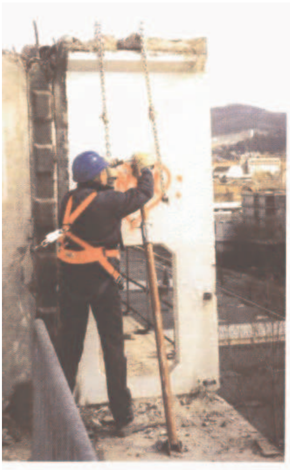
Bild 9: Benutzung des Auffangsystems Verbindungsmittel mit Falldämpfer und Auffanggurt bei der Balkondemontage
