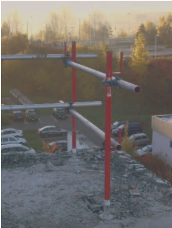
Bilder 2 und 3: Umlaufender Seitenschutz als kollektiv wirkende Schutzmaßnahme, Ausführung mit Geländerholmen und Kupplung
