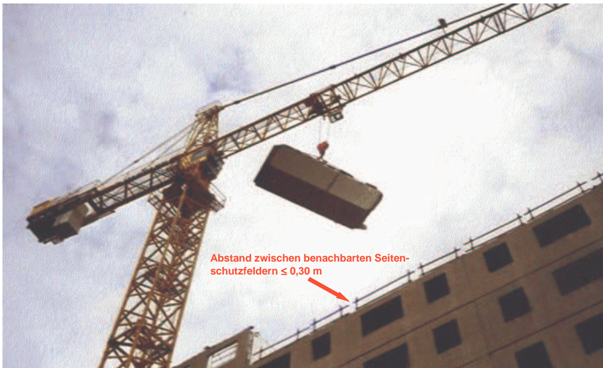
Bild 4: Umlaufender Seitenschutz (montagebedingt unterbrochen), zulässiger Abstand zwischen benachbarten Seitenschutzfeldern \leq 0,30 m
