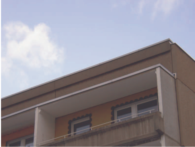
Bild 8: Plattenbau mit Dachtraufen- winkelementen
